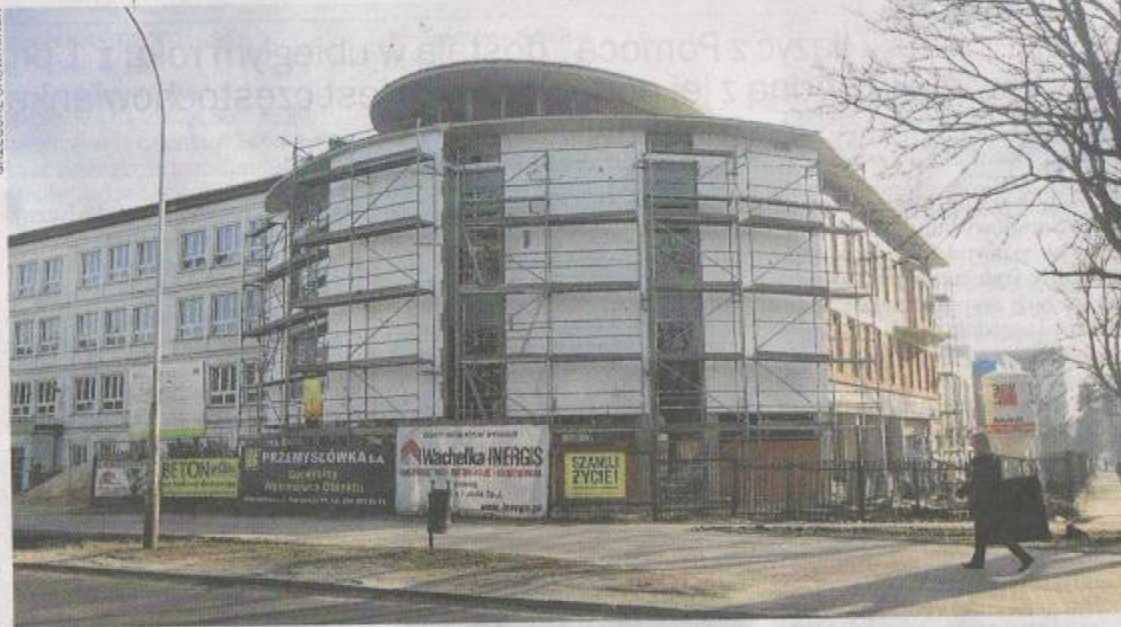
Nowe skrzydło „plastyka” wypełniło wschodnią pierzeję ul. Pułaskiego, nadając jej wielkomięjski charakter
